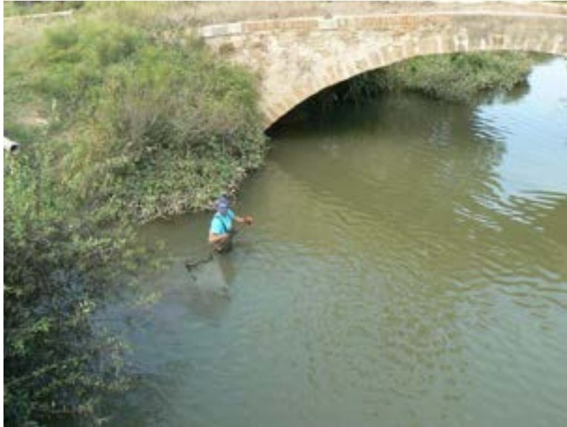
Rec de Molí, sota el pont de la Blaia.
