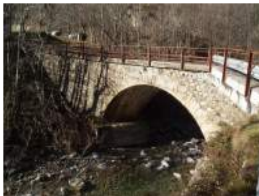
44. Pont de les Guielles (Queralt)
