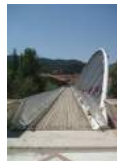
Pont de Calatrava
