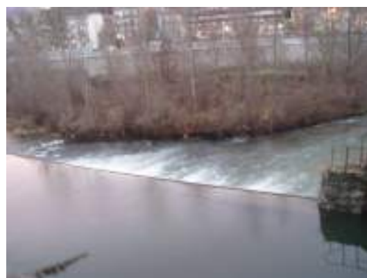
30. Presa de la central del Plà (Ripoll)
