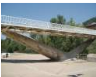
Un dels elements de recolzament del pont de Calatrava
