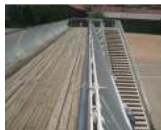
Passarel·la i escala del pont de Calatrava
