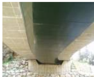
Vista des de sota el pont
