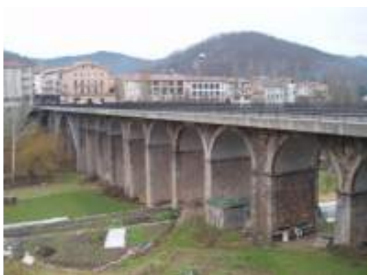
20. Pont Nou (Sant Joan de les Abadesses)
