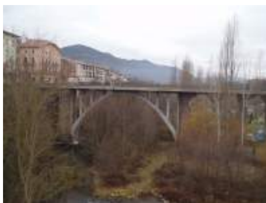
20. Pont Nou (Sant Joan de les Abadesses)
