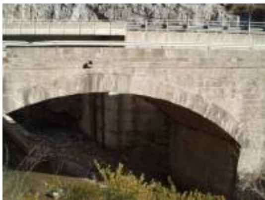
35. Pont de les Coves Vell (Ribes de Freser)
