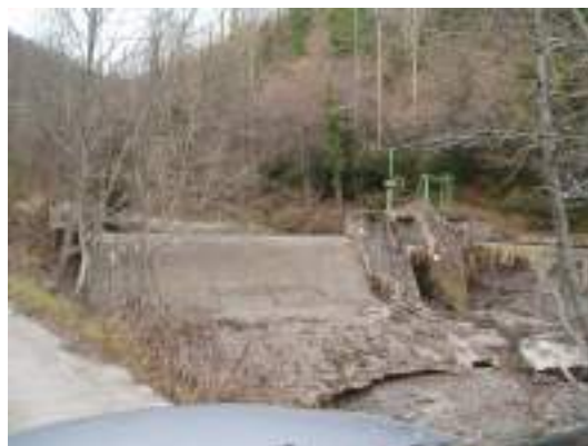
8. Presa de la central d'en Guasch (Llanars)
