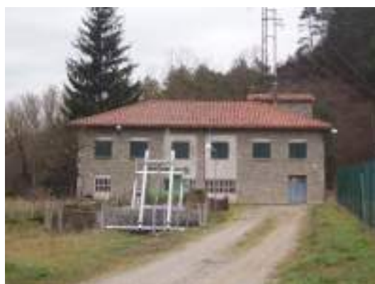
27. Central de Cal Gat (Ripoll)
