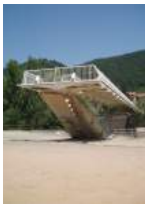
Pont de Calatrava
