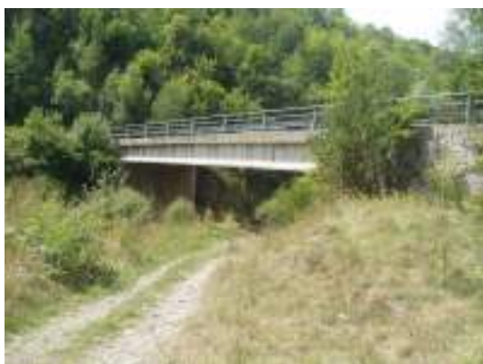
5. Pont de la Roca (Vilallonga de Ter)
