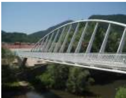
Pont de Calatrava
