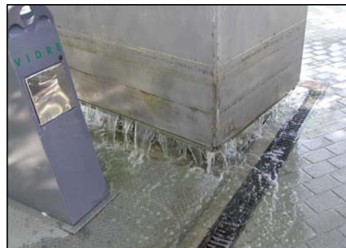
Extracció d'un contenidor soterrat inundat (Font: Ajuntament de Sarrià de Ter)
