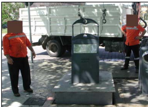
Extracció d'un contenidor soterrat (Font: Ajuntament de Sarrià de Ter)
