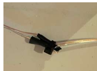
Fig. 53 Soldadura entre els cables.
