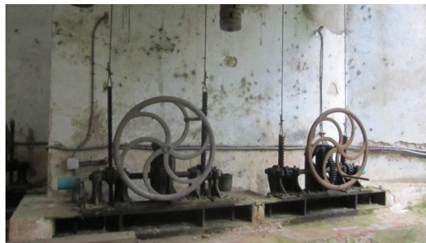
Comportes reguladores de la quantitat d'aigua que circula per la sèquia.
