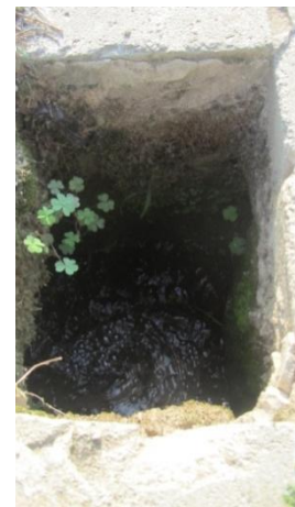
Diferents tipus d'ulls que serveixen per desviar l'aigua de les regueres terciàries o quaternàries cap a les hortes.
