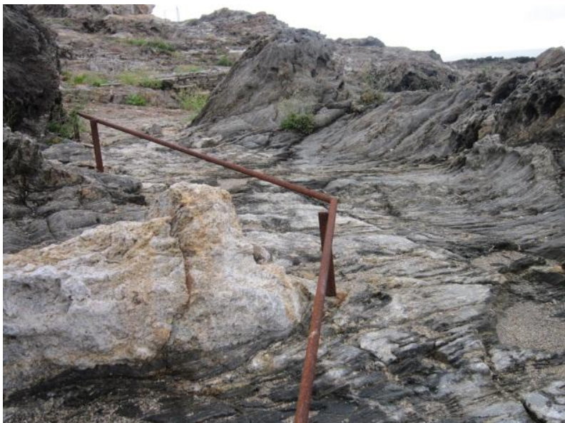
Imatge de la barana de ferro "corten". 43
