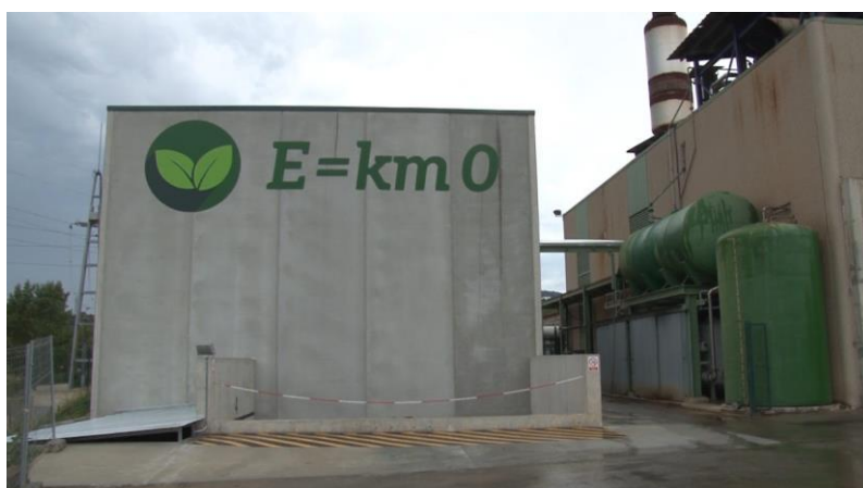
Edifici protector de la caldera de biomassa
