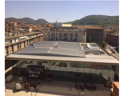
Instal·lació fotovoltaica a la Plaça Mercat
