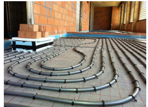
Fotografia feta durant la instal·lació del terra radiant a l'edifici
