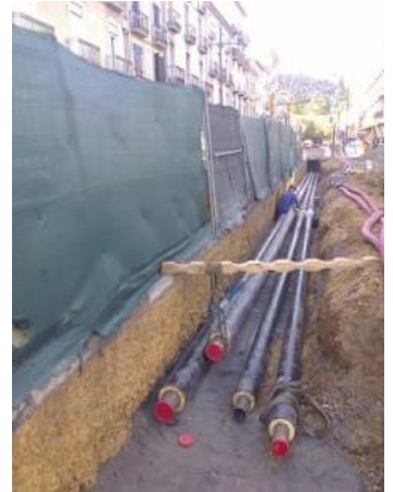
Foto durant la instal·lació de les canonades
