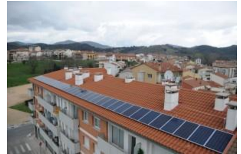
Instal·lació fotovoltaica al teulat
