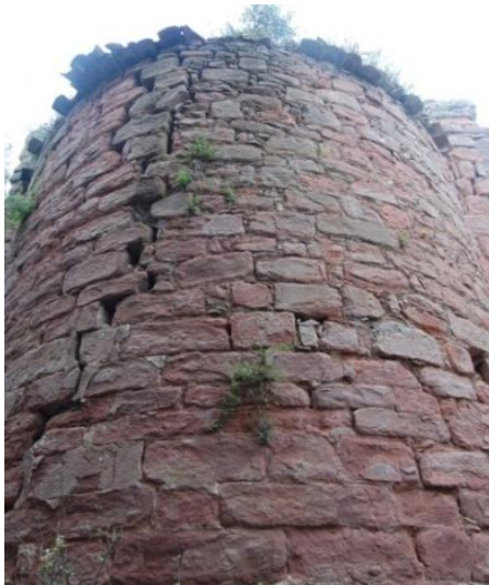
A l'esquerra, pedra sorrenca al detall de la façana de migdia.
