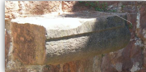
Pedra de gres treballada que està al mur de tramuntana per la part interior.
