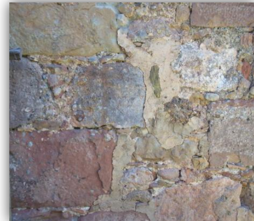
A la foto de la dreta trobem un exemple de conglomerat el qual pertany façana de la torre-campanar.
