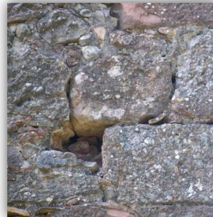
La foto de l'esquerra forma part d'un dels contraforts que hi ha al mur de tramuntana.
