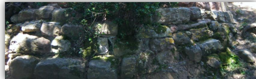
Detall de la part inferior de l'absis on trobem pedres sorrenques una mica malmeses.
