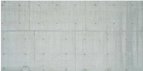
Imatge 20: Mur de formigó
