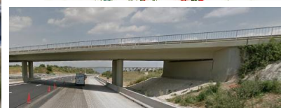
Imatge 29: Pont travessant l'AP-7
