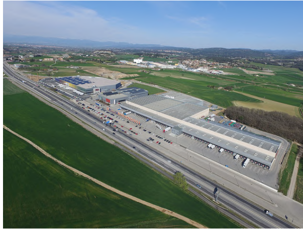
Figura 3: Imatge aèria de les instal·lacions de Bonpreu a Balenyà. Font: [5]
