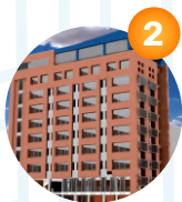
EDIFICIO ERNESTO SÁBATO
