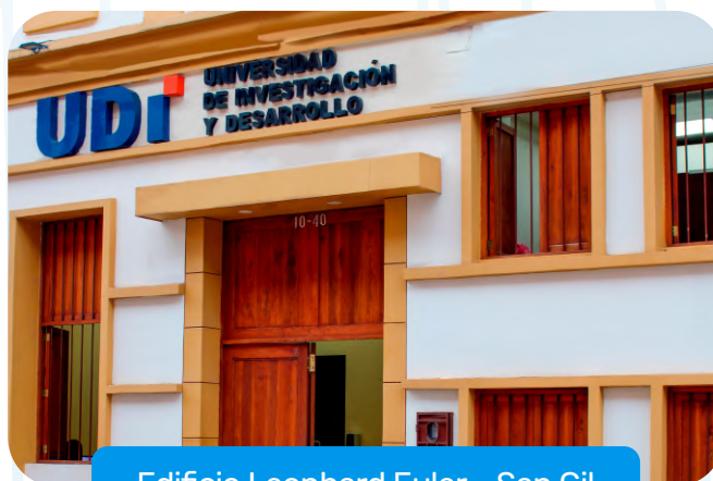
Edificio Leonhard Euler – San Gil
