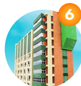
EDIFICIO DANIEL BERNOULLI
