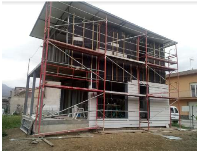
Figura 59. Aïllament de l'estructura de l'edifici
