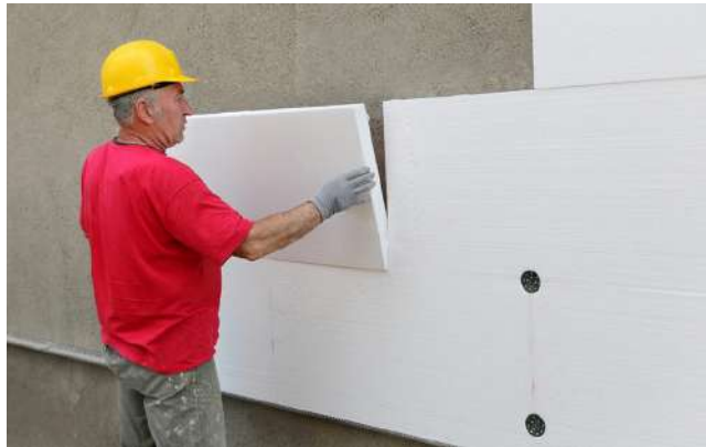
Figura 26. Aplicació de làmines de poliestirè
