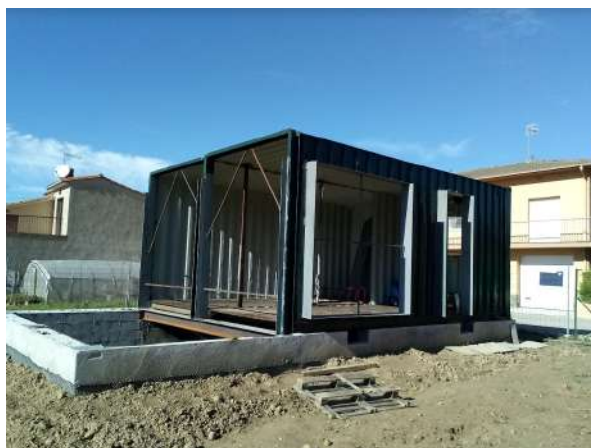
Figura 57. Col·locació dels contenidors de la planta baixa
