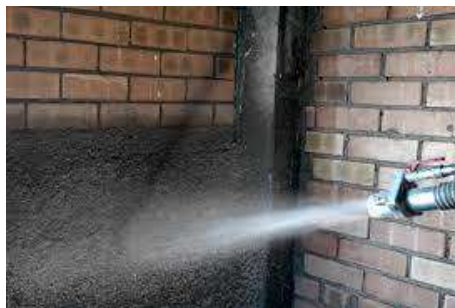
Figura 23. Insuflat de cel·lulosa
