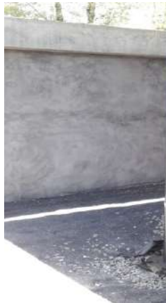
Figura 49. Parets de formigó del mòdul soterrat
