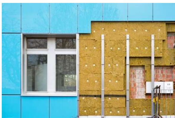
Figura 28. Panells de llana de roca
