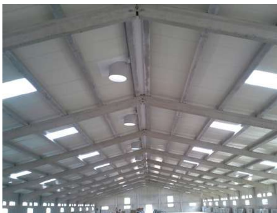
Figura 27. Aïllament d'un sostre amb plaques de fibra de vidre.
