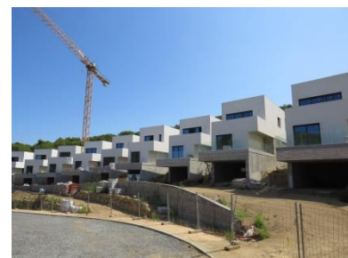
31. Peça que queda més lluny, en execució.
