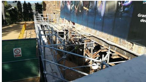
50. Obres subterrànies sota el castell.
