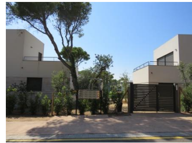
32. Peça que queda al mig, ja executada.
