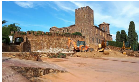
49. Màquines a Cap Roig encarregades de les obres de l'auditori semisoterrat adossat al castell.
